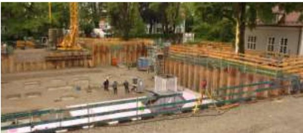
Ein großer Teil der Bauarbeiten konnte in diesem Jahr bereits erledigt werden und der Rohbau steht. Die Bauhauptarbeiten erledigte die Firma Filgis (Ottobeuren) mit Beton- und Stahlbetonarbeiten im Untergeschoss sowie Grundleitungen und einer Rigole zur Regenwasserversickerung. Beim Richtfest im November beschrieb Geschäftsführer Georg Filgis die unfallfrei verlaufenen Arbeiten, bei denen mit großer Umsicht auf den alten Baumbestand in unmittelbarer Umgebung der Baustelle geachtet wurde.
